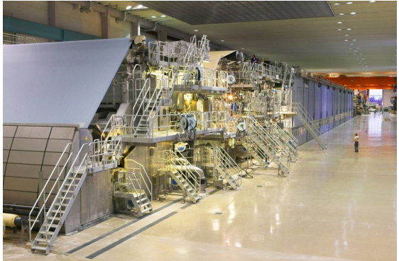
PM12 på Stora Enso Kvarnsveden i Borlänge
