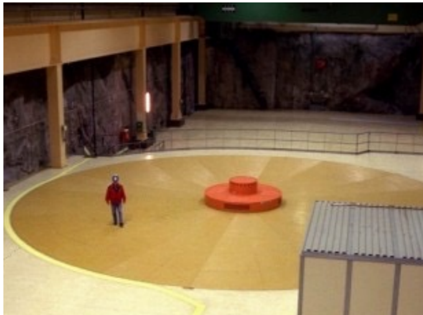
Harsprånget G5 vattenkraftverk 475 MW generator Rotor: 56 poler, 107 rpm, \varnothing 14 m Turbinrotor: \varnothing 6,6 m
