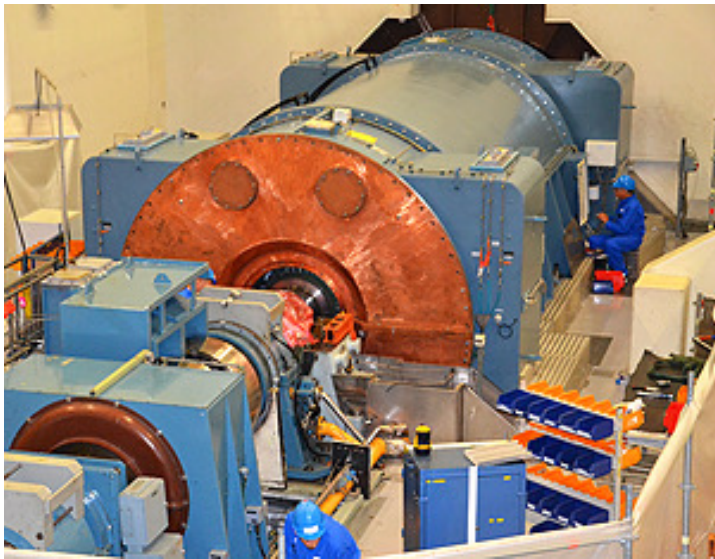
Forsmark 2 kärnkraftverk En av 2x580 MW generatorer Rotor: 2 poler, 3000 rpm
